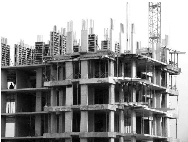
Рис. 4.13. Изготовление монолитных конструкций
